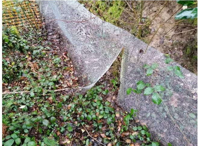
Dommage de la barrière antiretour à amphibien au sud de la zone du chantier
