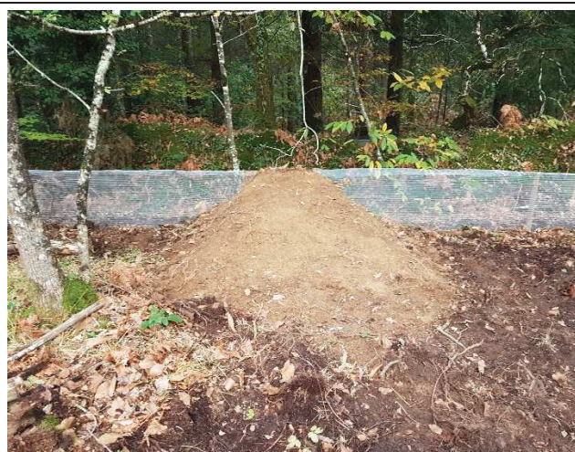
Photo 4 – tremplin en connexion avec un talus non impacté et cadré par les barrières anti-retour
